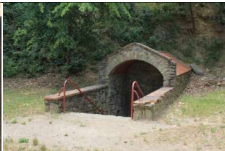
Fontaine des écureuils (f) sur espace public
