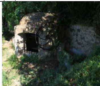
Puits ou pompe (a)
