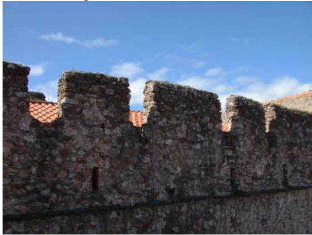
Mur crénelé de la façade nord (image mairie de Llauro)
